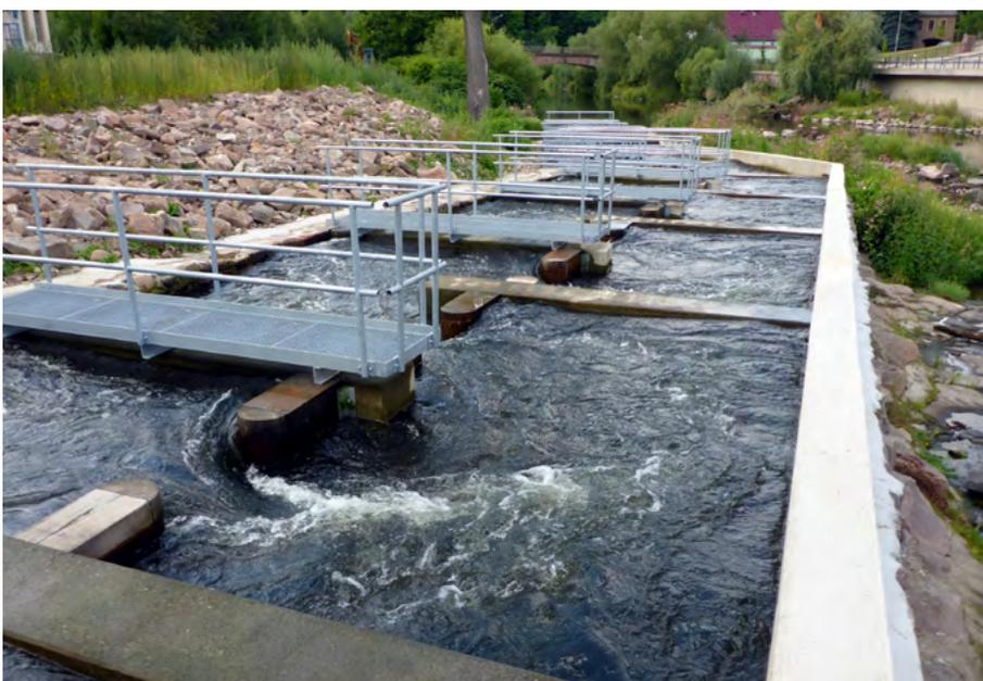
**Bild 6: Konventioneller Schlitzpass mit alternierender Beckenführung (Foto: www.ib-handrick.de).**
